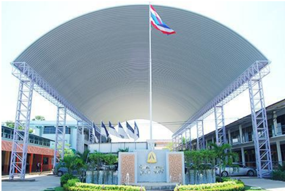
ภาพที่ 1 โครงสร้างเสาและคานใช้เหล็กฉาก (พงษ์ธิดา, 2560)
