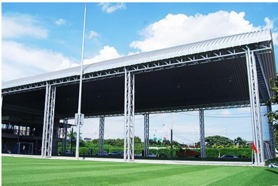
ภาพที่ 2 โครงสร้างเสาและคานใช้เหล็กแป๊ปกลม (พงษ์ธิดา, 2560)
