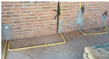
ภาพที่ 4. ความผิดพลาดของการติดตั้งระบบไฟฟ้าเนื่องจากการโค้งงอของท่อร้อยสาย
