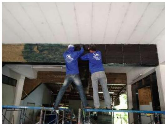
รูปที่ 12 การซ่อมแซมโดยวัสดุคอมโพสิตเสริมเส้นใย CFRP
