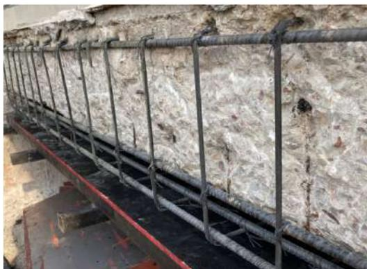
รูปที่ 11 การซ่อมแซมโดยวิธี Concrete Repair
