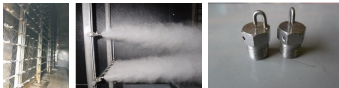
รูปที่ 3.2 ระบบพ่นละอองน้ำ (Fogging System)
