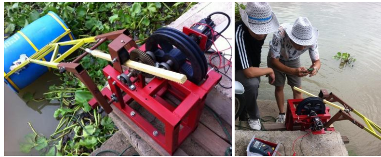
ภาพประกอบ 2 ลักษณะการติดตั้งทดลองเครื่องผลิตพลังงานไฟฟ้า
