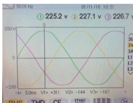
ก. รูปคลื่นของแรงดันที่สายแรงดัน 220 โวลต์ 3 เฟส
