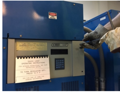
รูปที่ 9 ตู้ควบคุมการจ่ายกระแสแบบคงที่ (Constant Current Regulator : CCR)
